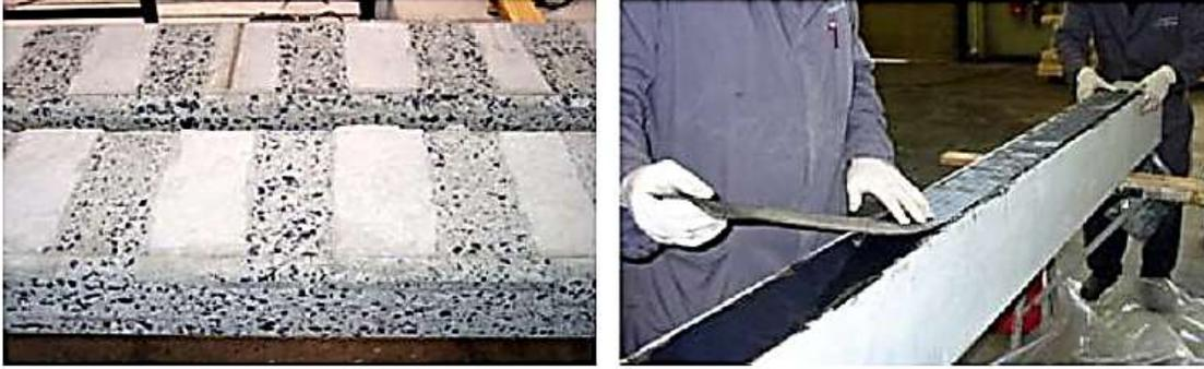
الشكل (13) تحضير السطح البيتوني ووضع صفائح CFRP فوق اللاصق الرطب.
