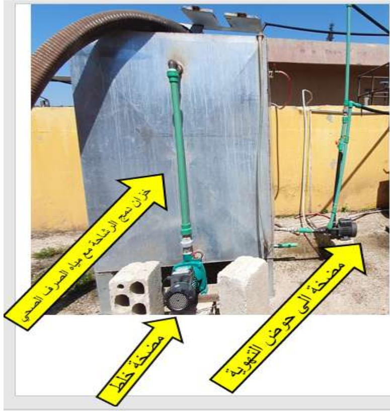
الشكل رقم (5) خزان دمج الرشاحة مع مياه الصرف الصحي للنموذج المصمم
