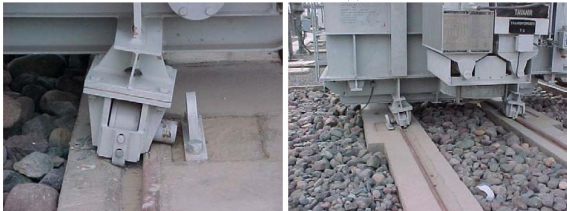
الشكل (7) خروج قواعد المحولات عن سكة التثبيت
