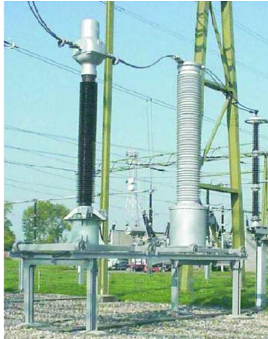
الشكل (14) تنفيذ الوصل عند حدوث انزياح نسبي كبير وتتنزاد القوى المطبقة على الناقل.
