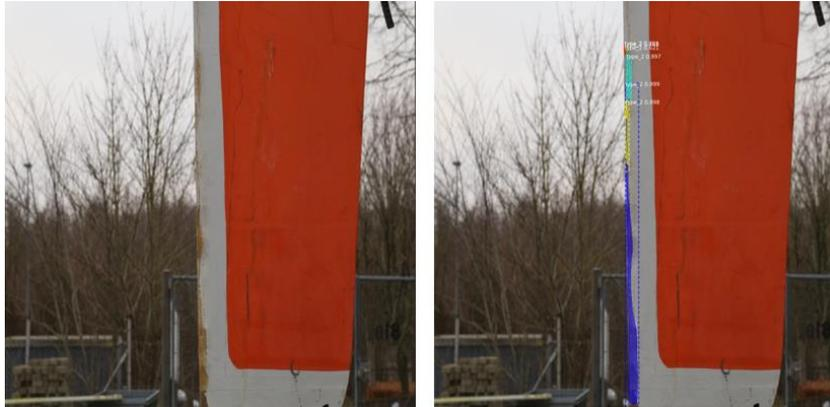
الشكل 14. خرج النموذج عند اختباره على صورة لتآكل من نوع SSD
