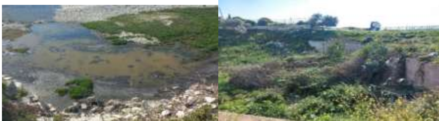
الشكل 8: موقع مصب للصرف الصحي غير المعالج إلى البحر والنمو الكثيف للنباتات حوله في منطقة برج إسلام، 2024/5/17.
