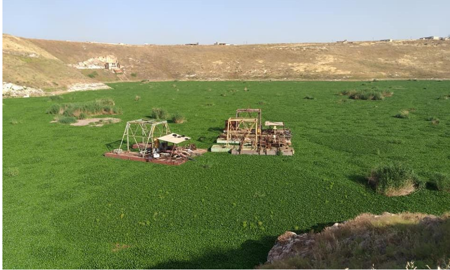
الشكل 1: زهرة النيل تغطي كامل بحيرة سد محردة وتهدد بتوقف مجموعة ضخ المياه العائمة على سطح البحيرة التي تؤمن مياه التبريد اللازمة لعمل محطة توليد محردة
