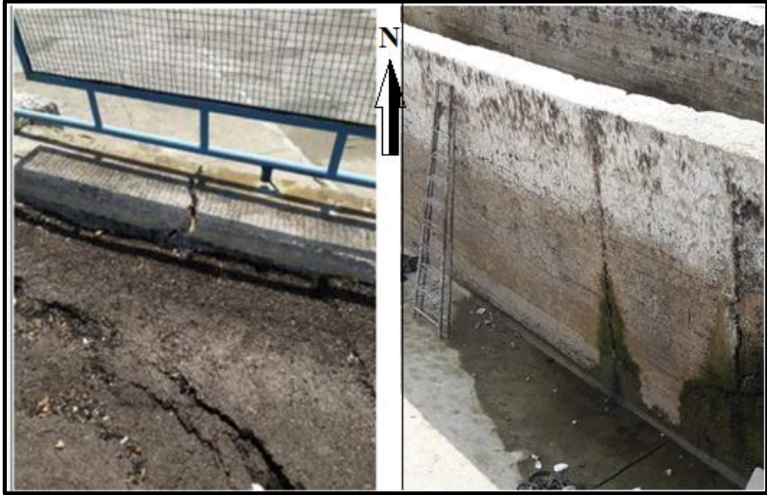
الشكل (3): فواصل وتشققات في جدران وأرضية الخزان وفي الطريق المحيط به
