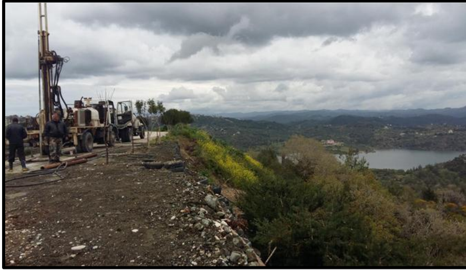
الشكل (5): صورة البئر المدروسة أثناء عملية الحفر،
